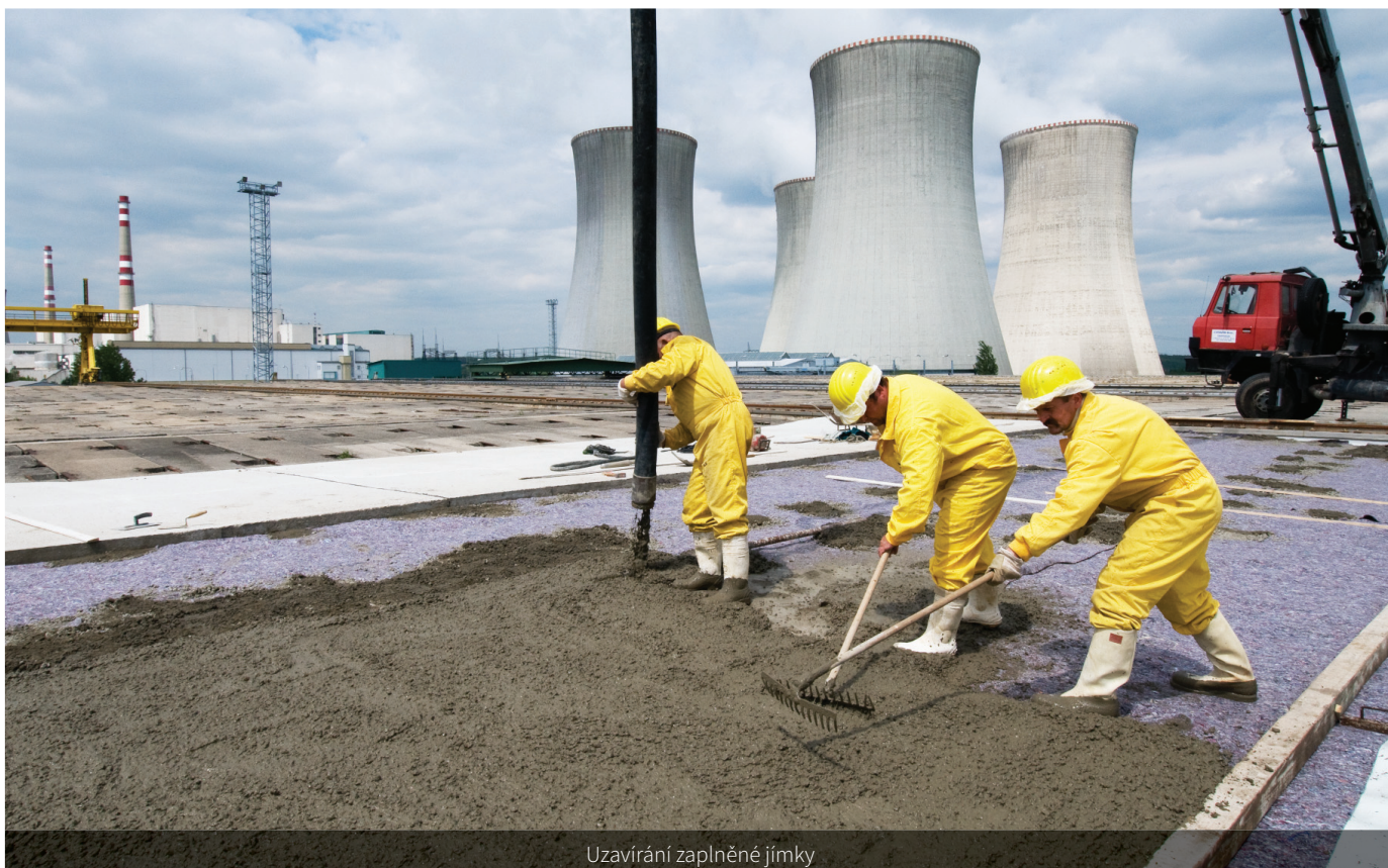
Ukládání obalových souborů s odpady do jímky
