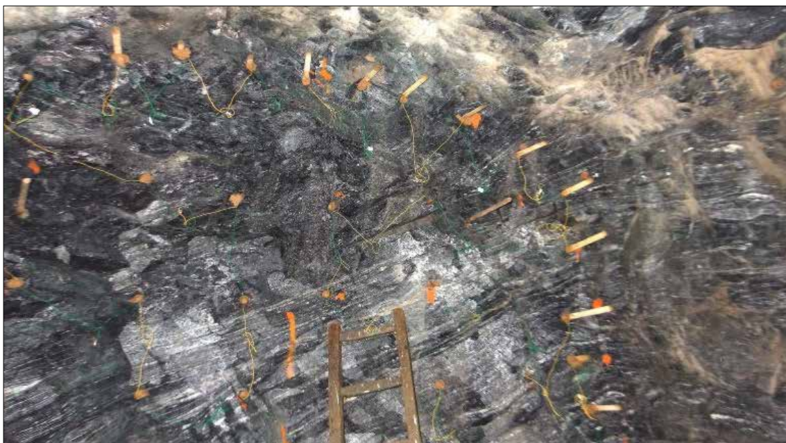
Detail nabité čelby s obrysovými vrty. ►
