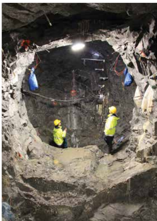
◀ Upravená rozrážka před instalací zátky
