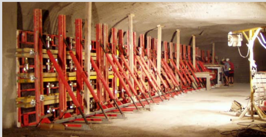
Projekt „Realizace uzavření komor v úložišti Richard“, výstavba vnitřní stěny hydraulické klece.
