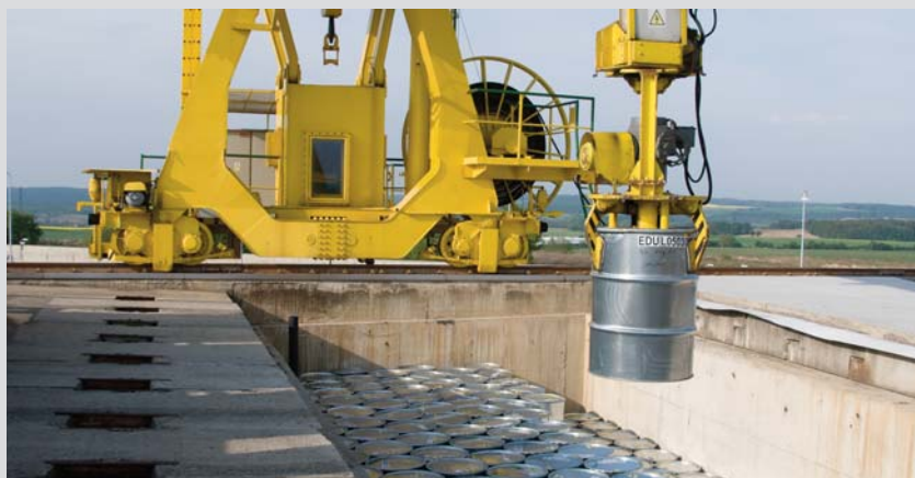
Umístování sudu s odpadem do ukládací jímky. Jeřáb je ovládán z kabiny chráněné stíněním proti účinkům ionizujícího záření.
