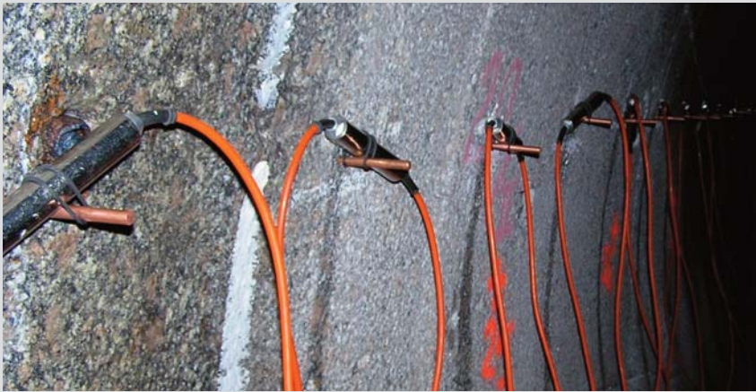
Štola Bedřichov - experimentální podzemní pracoviště Technické univerzity v Liberci - ukázka instrumentace geofyzikálních odporových měření ve stěně štoly.
