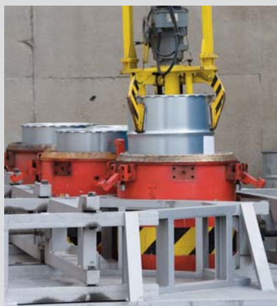
Vyjímání sudu s radioaktivními odpady ze stínícího transportního obalu při přejímce na úložišti Dukovany.
