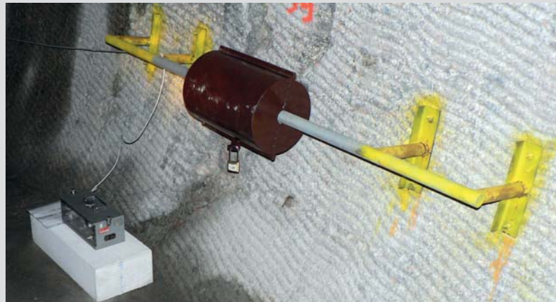
Tunel Bedřichov - 3D měření pohybů na puklině.
