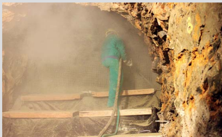
Experimentální výzkum technologie stříkaného backfilu.
