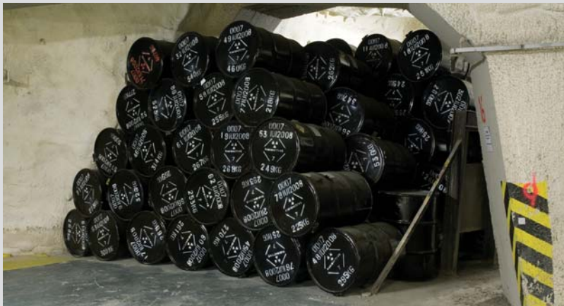
Uložené radioaktivní odpady v ukládací komoře úložiště Richard.
