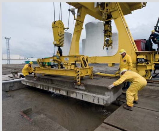
Uzavírání zaplněné jímky, kde byl volný prostor mezi sudy vyplněn betonovou směsí.
