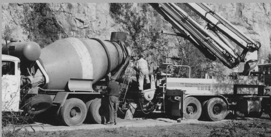
Uzavírání ÚRAO Hostim – betonáž
