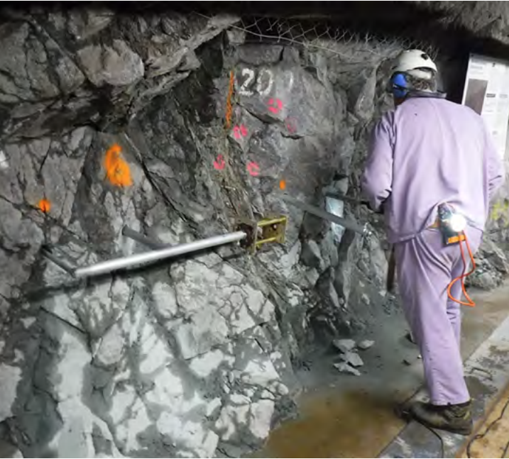
↑ Instalace konzoly pro osazení extenzometruv chodbě BZ-XIIJ
