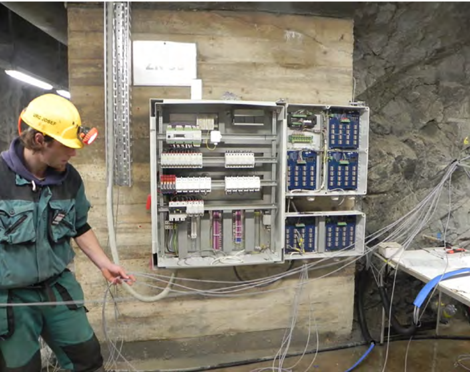
Instalace rozvaděčů a kabeláže
