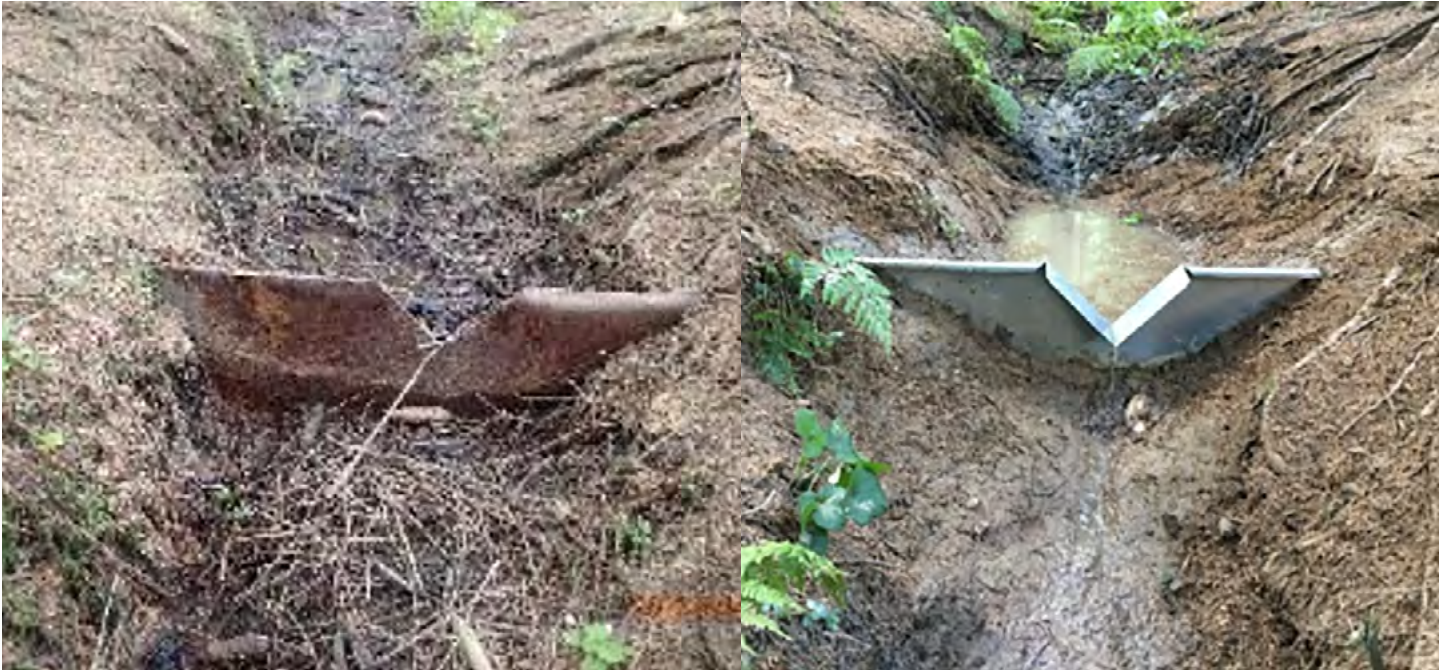
↑ Ukázka původní a nové instalace přelivů na povrchové lokalitě
