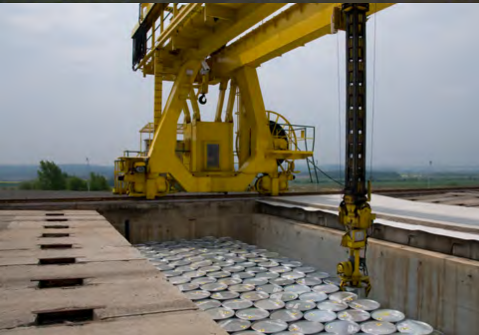
Úložiště radioaktivních odpadů Dukovany
