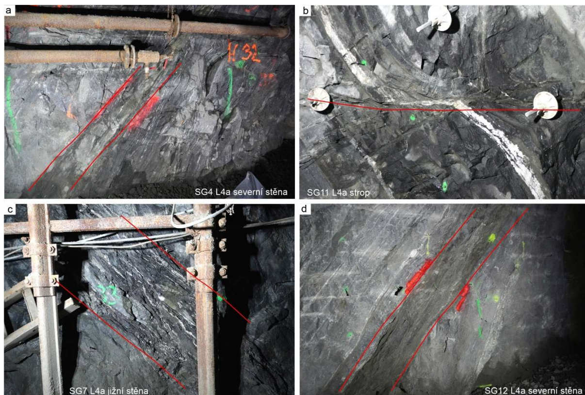
Obr. 25 Terénní fotografie ukazující příklady kritických struktur v chodbě L4a. (a, b) Zlomové zóny vyplněné chloritem, jílem a karbonáty, (c, d) Zóny křehce reaktivované metamorfní foliace s intenzivní chloritizací původně biotitem bohatých poloh.
