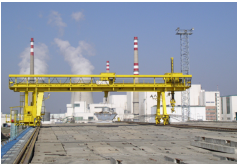
Úložiště radioaktivních odpadů Dukovany
