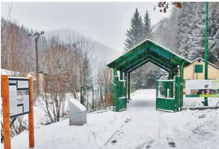
Úložiště radioaktivních odpadů Bratrství
