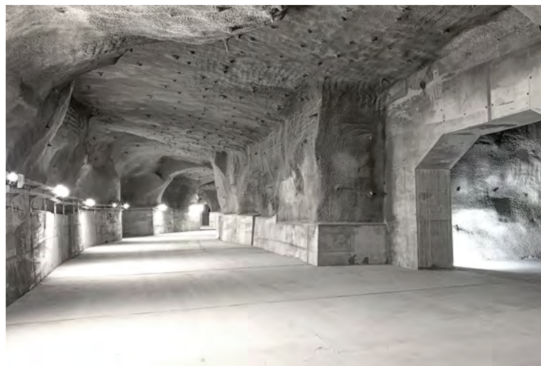
Úložiště radioaktivních odpadů Richard
